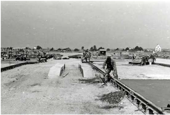
Betonieren der Rollwege
